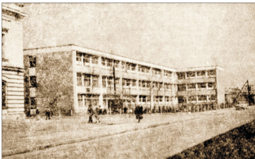
Clădirea Liceului nr. 3 din Bârlad, azi Grupul Școlar Industrial “Al.I. Cuza” (mai, 1973).
